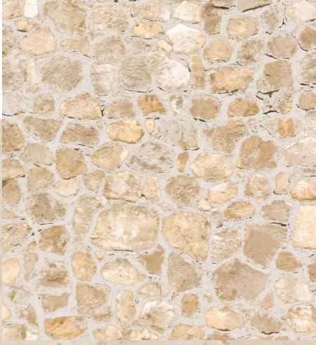
Marés Wände mit Fugen
